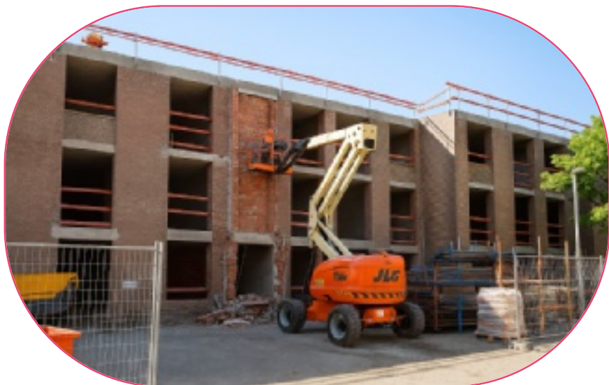
Renovatie van 30 bestaande appartementen met uitbreiding van 5 extra appartementen.
